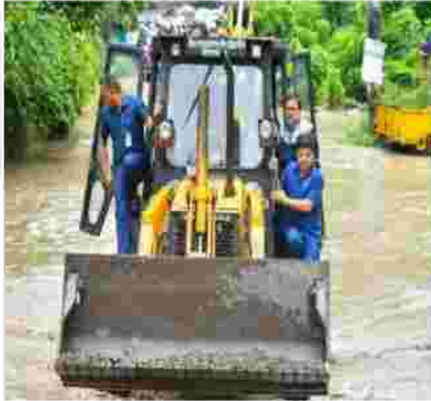
उत्तराखण्ड में सड़क बनाने से जालम जल का पानी काटी का मुहाने, उत्तराखण्ड
