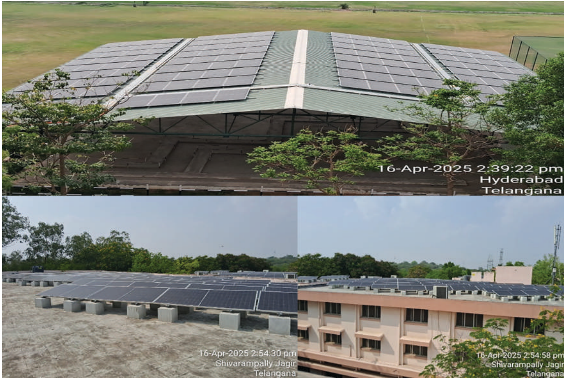
चित्र 3.13: सरदार वल्लभभाई पटेल राष्ट्रीय पुलिस अकादमी, हैदराबाद में 525 किलोवाट का सौर संयंत्र स्थापित किया गया
