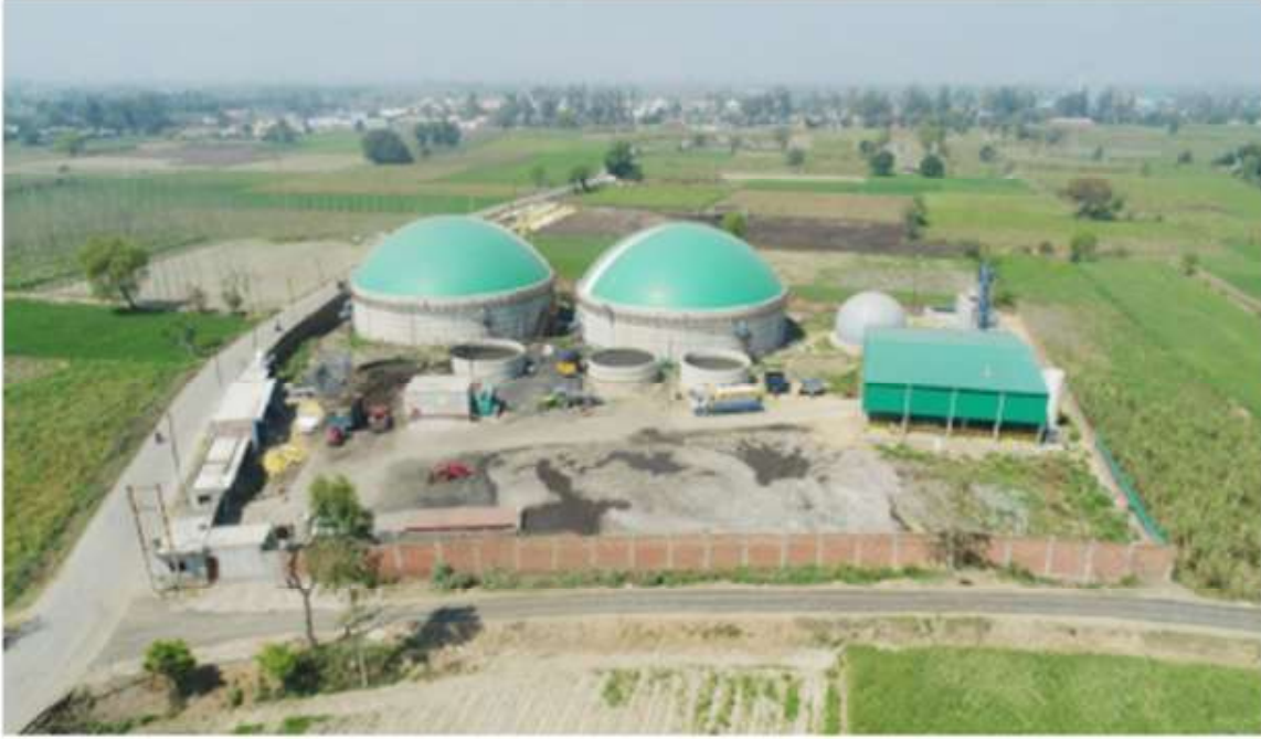
चित्र 6.2: मेरठ, उत्तर प्रदेश में मेसर्स आनंद मंगल इंफ्रा डेवलपर्स प्राइवेट लिमिटेड द्वारा 5980 किलोग्राम/दिन क्षमता का बायोसीएनजी संयंत्र स्थापित किया गया
