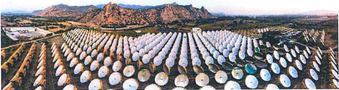
माउंट आबू, राजस्थान में 16 घंटे के थर्मल भंडारण (770 सौर डिश) के साथ 1 मेगावाट समतुल्य (3.5 मेगावाट घंटे) सौर ताप विद्युत संयंत्र
