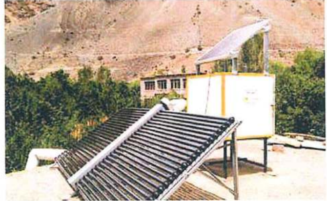
मिनजी ग्राम, कारगिल जिले में संस्थापित सोलर एप्रिकोट ड्रायर सह स्पेस हीटिंग प्रणाली की संस्थापना
