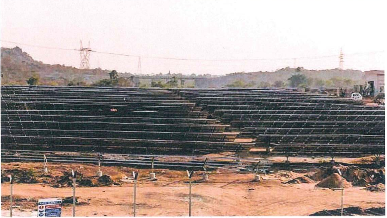
बीडीएल, इब्राहिम पट्टनम में 5 मेगावाट की सौर परियोजना (निर्माणाधीन)
