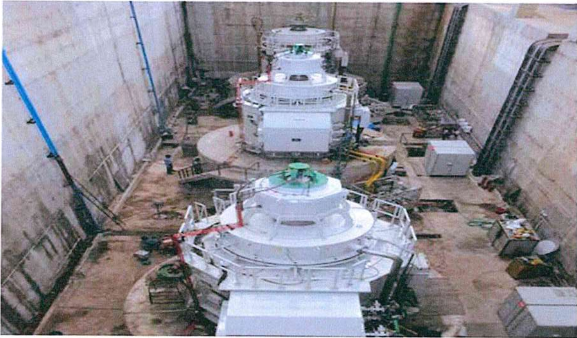
चित्र 4.6: ओडिशा के क्योरॉझर जिले में अगस्त 2020 में चालू किए गए बैतरणी एसएचपी (24 मेगावाट) का टीजी सेट
