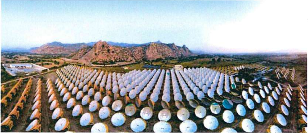
चित्र 7.7: परवलयिक डिश सोलर कंसंट्रेटर पर आधारित/ मेगावाट समतुल्य (3.5 मेगावाट थर्मल) सौर पावर प्लांट
