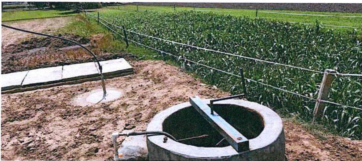
चित्र: 5.2 ग्राम चक गुलाम, जिला फजिल्का में 6 घन मीटर क्षमता का बायोगैस संयंत्र
