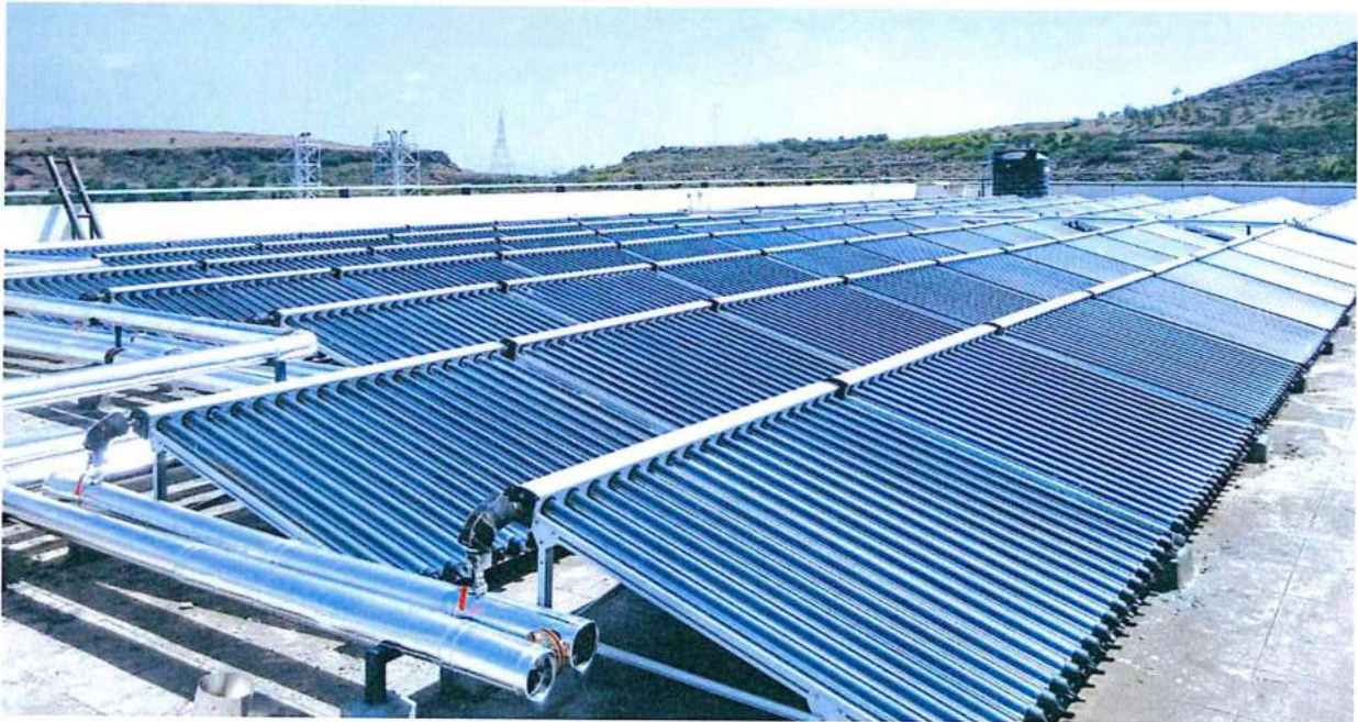
चित्र 1 : एशियन पेंट्स लि. खंडाला, महाराष्ट्र में संस्थापित सीपीसी आधारित प्रेसराइज्ड हॉट वाटर प्रणाली
