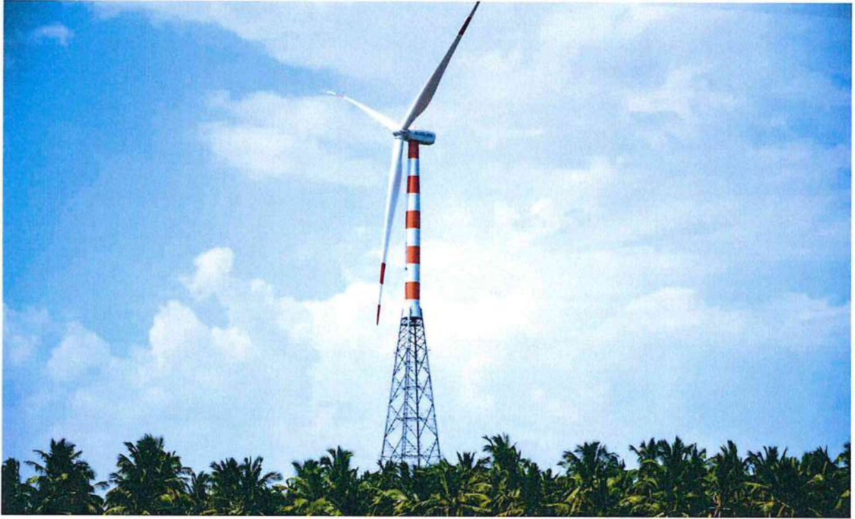
सेकी ट्रेंच-। के तहत तमिलनाडु, भारत स्थित चंद्रागिरी में 250 मेगावाट पवन फार्म में स्थापित 2.1 मेगावाट क्षमता का पवन मिल
