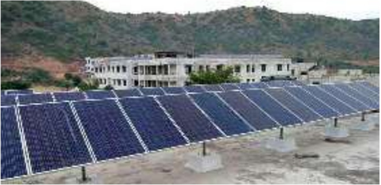
सेकी द्वारा स्थापित एसएस कॉलेज ऑफ इंजिनियरिंग, उदयपुर राजस्थान में 300 किलोवाट पीक का ग्रिड सम्बद्ध सौर रूफटॉप संयंत्र
