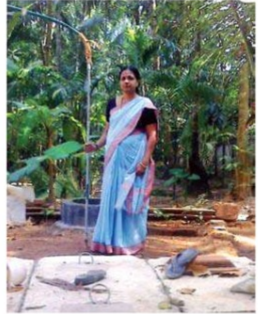
शेयंगड, पोन्नानी, केरल में 2 घन मी. क्षमता का दीनबधु मॉडल बायोगैस संयंत्र
