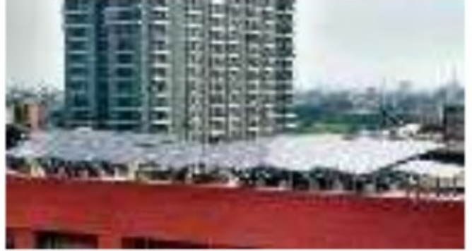
सेकी द्वारा सेठ आनंद राम जयपुरिया एजुकेशन सोसायटी, जयपुरिया इंस्टीट्यूट ऑफ मैनेजमेंट, इंदिरापुरम, गाजियाबाद उत्तर प्रदेश में संस्थापित 170 किलोवाट पीक का ग्रिड संबद्ध सौर रूफटॉप संयंत्र
