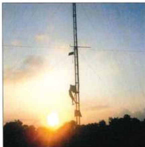
चित्र 10.18: गुजरात में 100 मीटर डब्ल्यूएमएस को चालू करना
