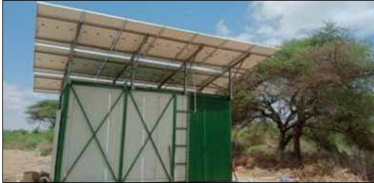
चित्र 10.6: केन्या में थर्मल एनर्जी बैकअप एप्लिकेशन के साथ 5 एमटी सौर चालित कोल्ड स्टोर
