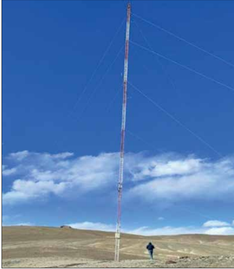
चित्र 10.12: कारगिल में स्थापित 50 मीटर पवन निगरानी स्टेशन
