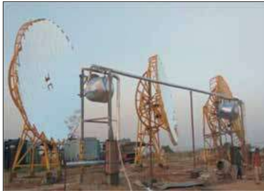
चित्र 7.18: पाइप और इंसुलेसन के साथ कास्ट ऑयरन रिसेवर की स्थापना
