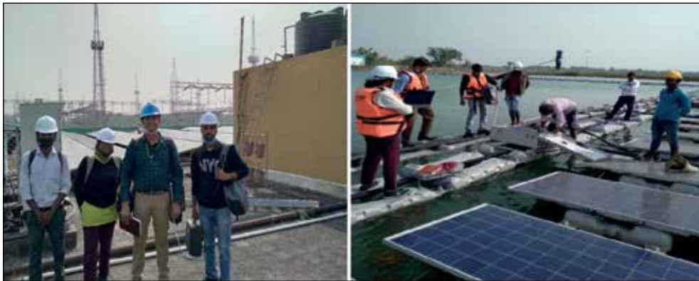
चित्र 10.10: रूफटॉप में पीवी मॉड्यूल का निरीक्षण और परीक्षण (बाएं) और फ्लोटिंग पीवी विद्युत संयंत्र
