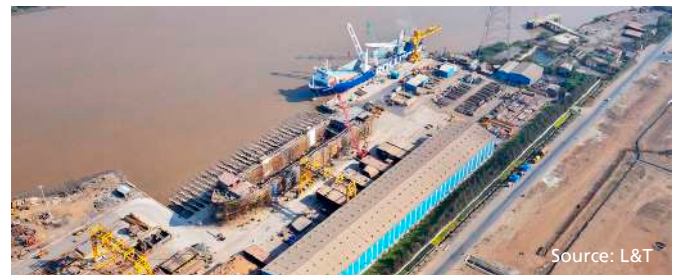
Figure 110 - L&T Hazira site
