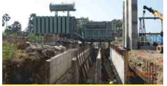
50 एमवीए ट्रांसफॉर्मर्स स्थापना प्रगति पर।
