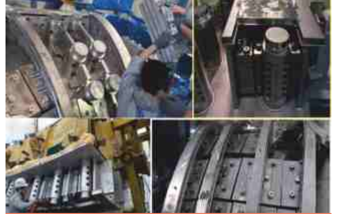
क्रम में : वैक्यूम वेसल (वीवी) सेक्टर में असेंबली के लिए आईडब्ल्यूएस नीचे किया गया, वीवी के बाहरी और आंतरिक आवरणों के बीच रखने के लिए आईडब्ल्यूएस असेंबली के चारों तरफ चलीचा सहारा, आईडब्ल्यूएस की असेंबली और बाहरी आवरण की वेल्डिंग के लिए तैयार होने के बाद का वीवी खंड दृश्य
