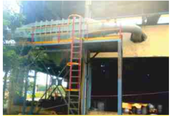
क्लोरीनेशन सेक्शन में सॉलिड ट्रेप
