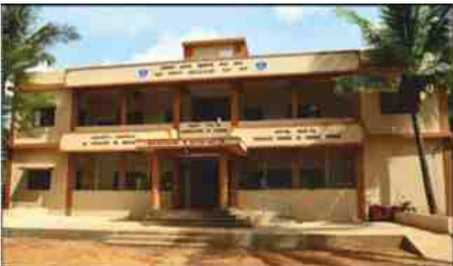
बारे, जिला उत्तर कन्नड, कर्नाटक में शासकीय उच्चतर प्राथमिक विद्यालय का निर्माण
