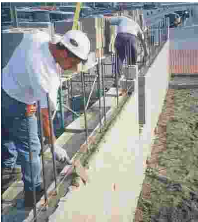
चित्र-3 : ( ऊपर ) इंडोनेशिया (Indonesia) में कॉम्फाइट भवन निर्माण ( 4 ) और ( नीचे ) कनाडा (Canada) में प्रबलित निर्माण ( 5 )
