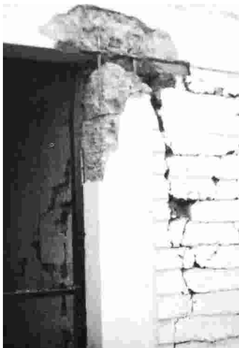
चित्र-17 : सन् 1985 में चिली के लोलियो (Llolleo) में आये भूकम्प के कारण कॉन्क्रिट भवन निर्माण से निर्मित अवसंरचना को हुयी क्षति का दृश्य ( 1 )
