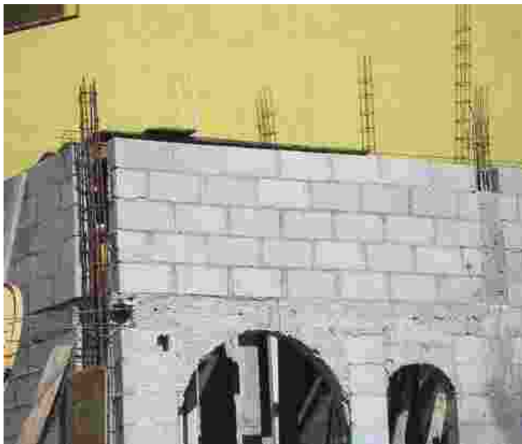
चित्र-5( ब ) : मैक्सिको में कॉन्फाइन्ड भवन निर्माण का दृश्य ( 1 )
