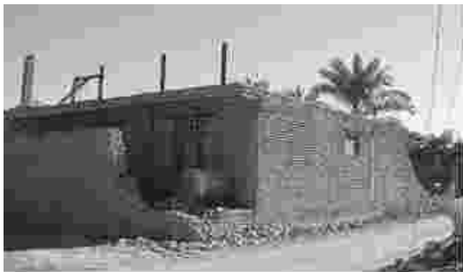
चित्र-22 ब : 2003 में बांम (Bam) में आये भूकम्प के कारण ईरान में कॉन्फाइन्ड भवन निर्माण तकनीक से बने भवनों में क्षति का दृश्य ( 10 )
